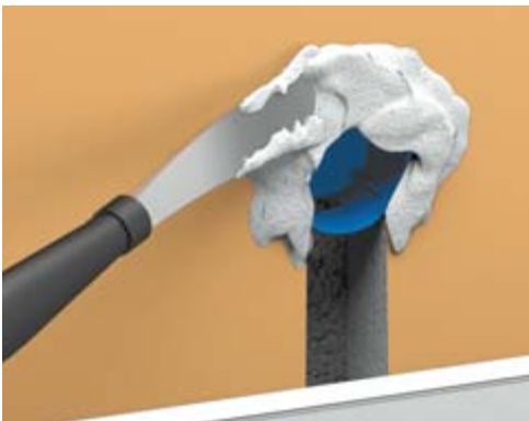
Рис. 7.11. Шаг девятый: коробка обмазывается штукатуркой снаружи так, чтобы между ней и отверстием не оставалось зазоров
