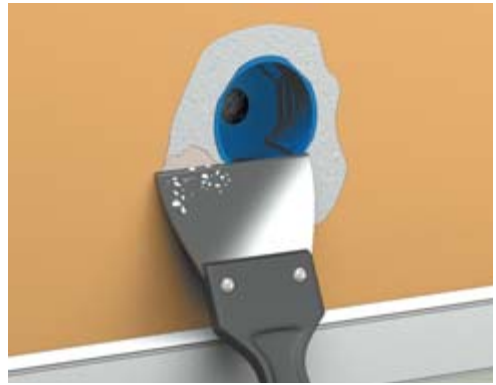
Рис. 7.13. Шаг одиннадцатый: после того как штукатурка подсохнет, шпателем подравниваются края поверхности и удаляется смесь из коробки
