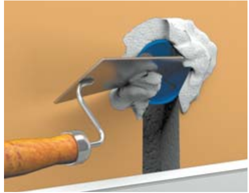
Рис. 7.12. Шаг десятый: мастерком или шпателем удаляются излишки смеси
