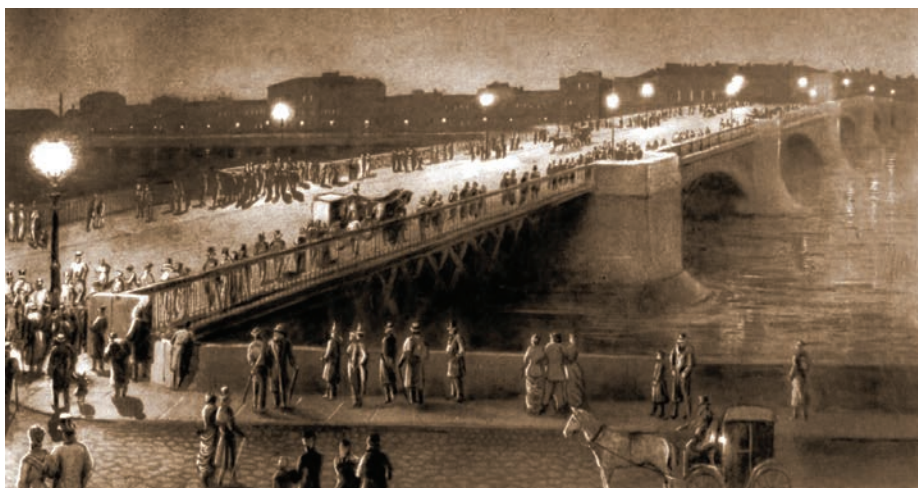
Литейный мост в Санкт-Петербурге. Первый мост с электрическим освещением
