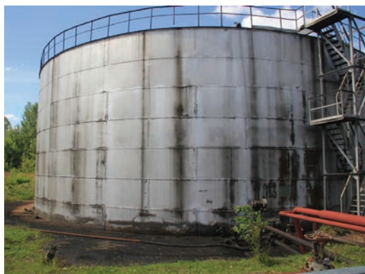
Старинный резервуар В.Г. Шухова на Ярославском нефтеперерабатывающем заводе
