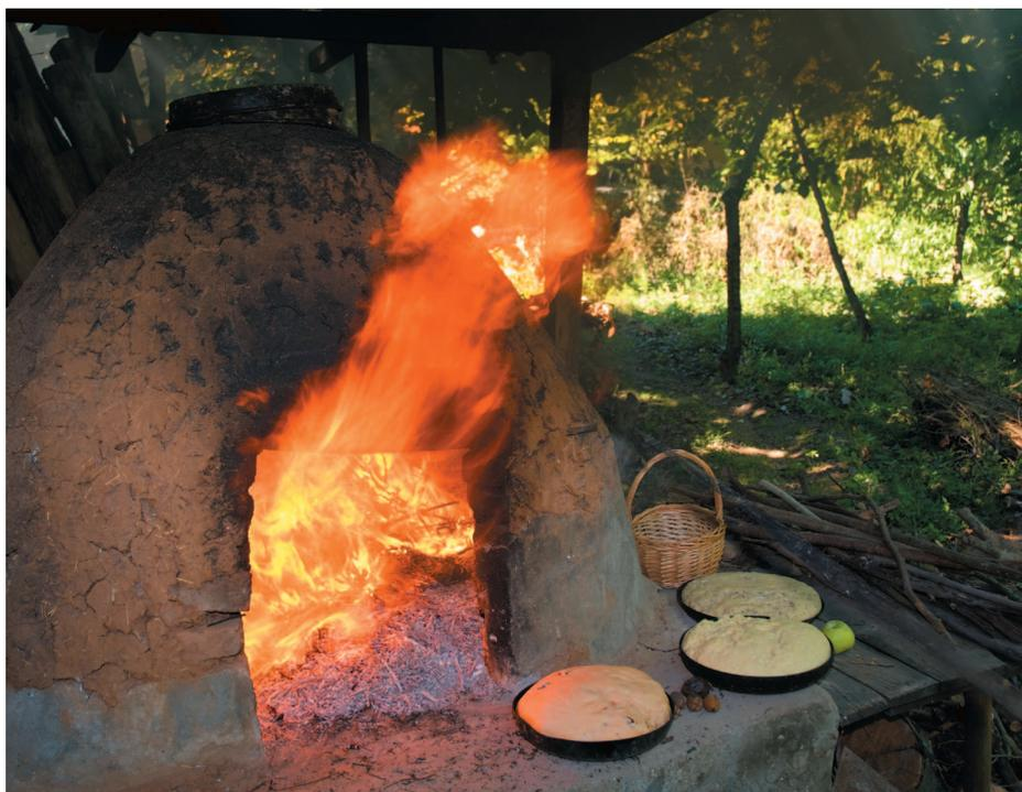
чи-сырцы, или применялось битье (технологически эта лепка представляла собой именно битье, уплотнение увлажненного глиняного массива деревянной колотушкой-чекмарем). Сооружение свода велось по деревянной форме-кружалу, которое впоследствии попросту выжигалось. Иногда, для упрощения, делался каркас из прутьев и обмазывался глиняным раствором. Каркас, ставший ненужным, мог выжигаться в процессе сушки печи, а мог и оставаться внутри глинобитного массива, если обмазку вели с двух сторон.
