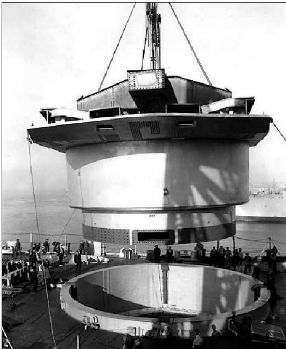
Установка башни главного калибра
