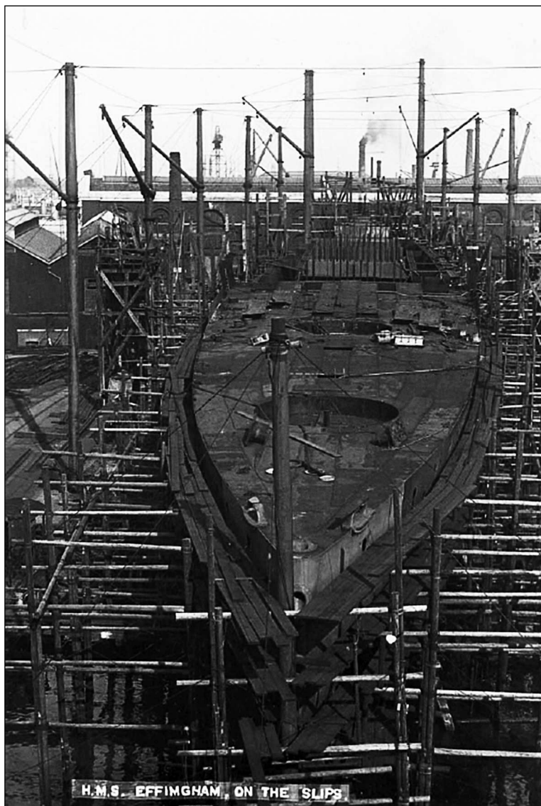
Вверху: крейсер «Эффингем» на стапеле Внизу: спуск на воду крейсера «Фробишер»
