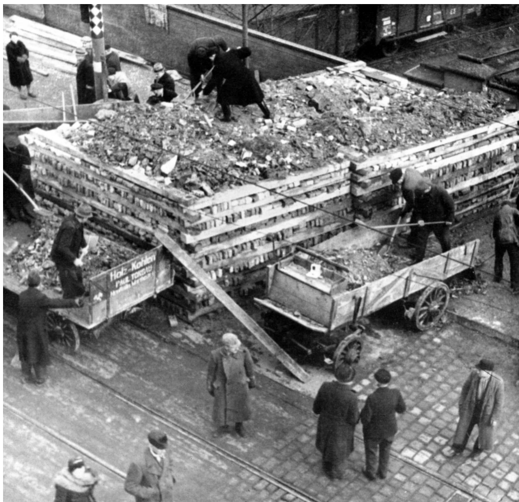
Строительство типичной для Германии баррикады поперек улицы. Стенки такого сооружения образовывали деревянные брусья или рельсы, а заполнялось оно камнями и землей. Подобные баррикады не преодолевались танками и выдерживали попадание снарядов до 152-мм калибра.
