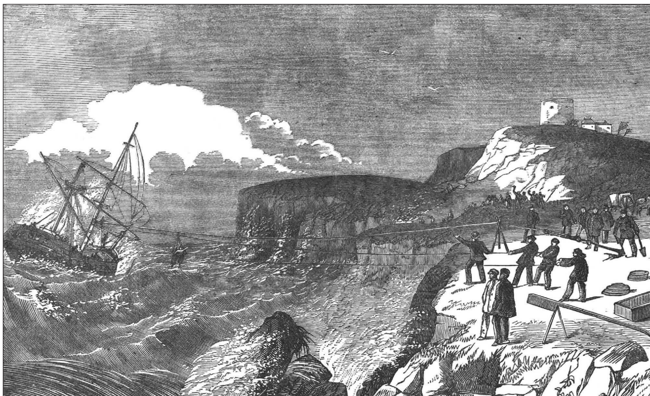
Снятие людей с гибнущего судна на берег при помощи линеметательного (так называемого ракетного) аппарата. Гравюра 1870-х гг. (Annual Report of the Chief of the Revenue Marine Bureau for the Fiscal Year Ending June 30, 1873, Showing the Operations of the Revenue Marine and the Life-Saving Service. Washington: Government Printing Office, 1873)
