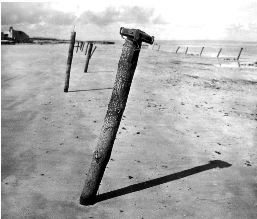
Типовое немецкое береговое препятствие – деревянная надолба с установленной на вершине миной. Сотни тысяч подобных преград были оборудованы вдоль побережья Нормандии по приказу Роммеля в течение нескольких месяцев, предшествовавших вторжению союзников.
