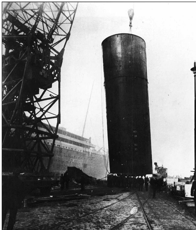
Слева и сверху: февраль 1911 г., на «Олимпик» монтируют дымовые трубы, корпус перекрашивается в традиционный для компании черный цвет
