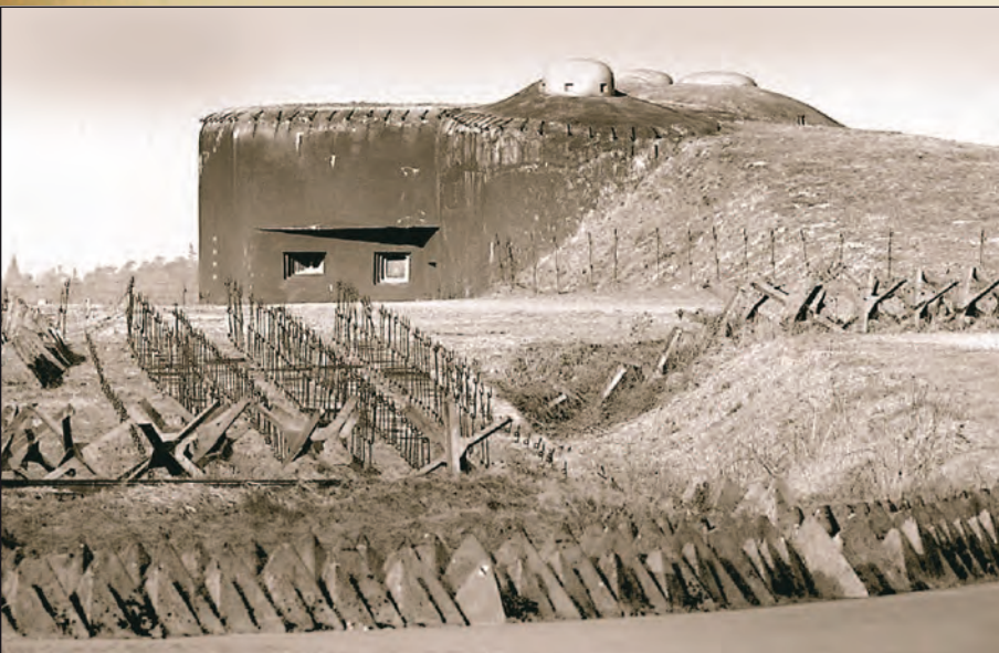
Бункер чехословацкой линии укрепления в Судетах, так называемой линии Бенеша. 1938 г.
