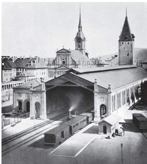
Рис. 1.3. Железнодорожная станция Берна (примерно 1860–1865 гг.) Одна из первых построек в Берне, оснащенных новыми согласованными часами. Двое часов едва заметны над овальными арками внешней части здания вокзала.
