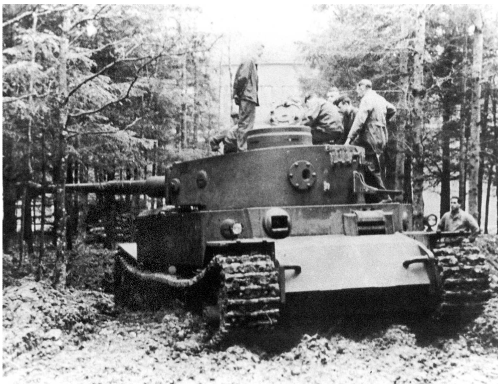
Танк VK4501(P) с установленной башней во время полигонных испытаний
