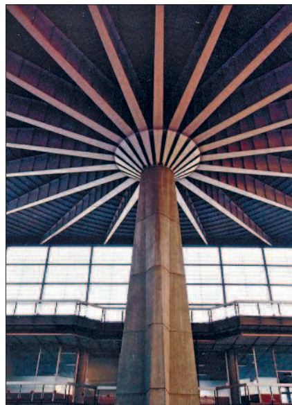
«Зонтичные» перекрытия Дворца труда. Турин. Италия
