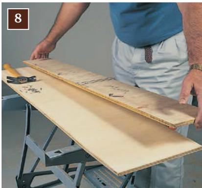
Для сборки шаблона направляющей для дисковой пилы прибейте или привинтите узкую полосу сверху широкой. Заводская кромка на узкой полосе должна быть с внутренней стороны. (На фото это кромка, ближайшая к молотку.)
