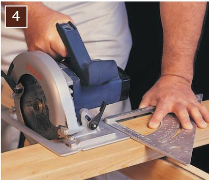
**4** Для обеспечения перпендикулярности пиления используйте в качестве направляющего упора угольник, который могут называть по фирменному названию Speed Square. Приложите угольник к кромке заготовки и перемещайте пилу вдоль него. Чтобы при этом держать пилу двумя руками, закрепите угольник струбциной/струбцинами.
