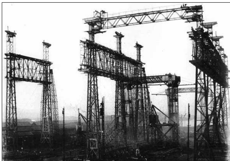
Верфь «Харлэнд энд Волфф» в Белфасте – место, где родился «Титаник» и его собратья. Верхний снимок сделан во время возведения ферменных перекрытий над стапелями №2 и 3. Справа: 200-тонный плавкран, использовавшийся при достройке судов наплаву. Внизу: декабрь 1908 г. – на стапеле №2 начаты работы на «Олимпике»
