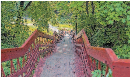
Лестница, спуск в Дьяковский овраг
