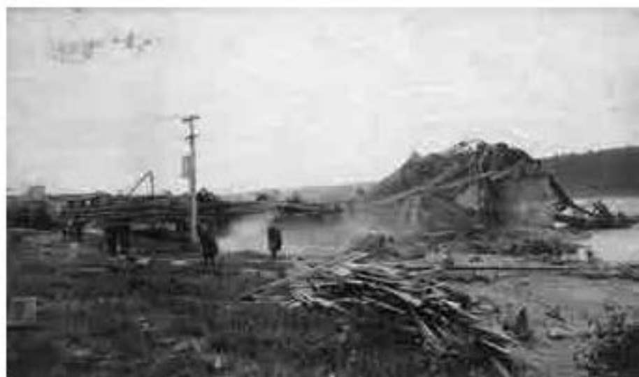
Сцена разрушения после трагедии 1907 года при строительстве Квебек-Бриджа через реку Святого Лаврентия в Квебеке в Канаде.
