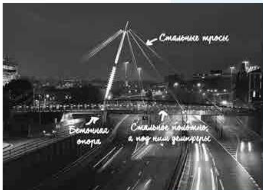
Пешеходный мост Нортумбрийского университета построили в 2007 году, и он соединяет две основные части территории университета в Ньюкасле апон Тайне в Англии.
