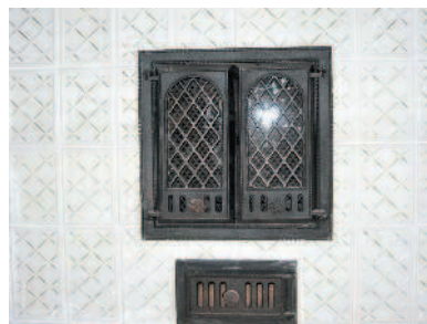
Топочная дверца печи-камина (вверху). Малая нижняя дверца закрывает поддувало. Обе дверцы снабжены системой подачи воздуха в зону горения. Таким образом, через нижнюю дверцу подается первичный воздух. Но его можно дополнить, регулируя размер щелей в верхней дверце
