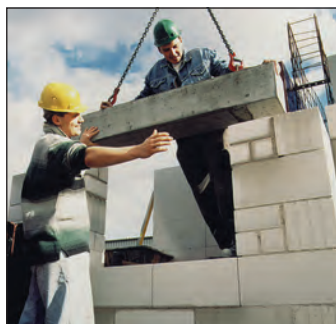
Рис. 1.3. Каменщики и бетонщики
