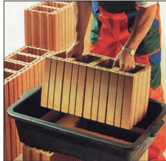
Рис. 3.16. Установка шлифованных заполняемых строительных блоков в шумозащитной стене
