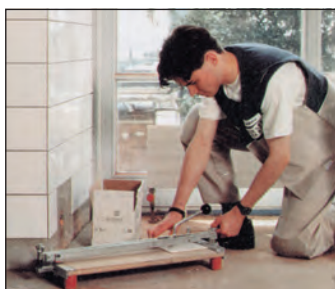
Рис. 1.8. Плиточник, укладчик плит и мозаики
