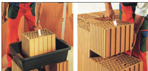
Рис. 3.12. Кладка стен из шлифованных строительных блоков
