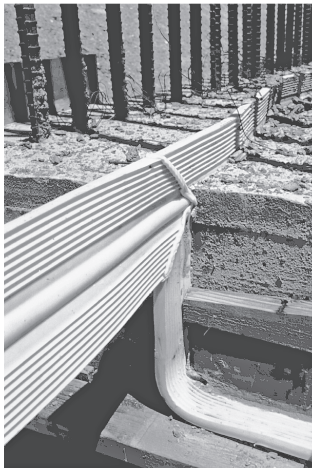
Рис. 2.32. Контроль качества обеспечивает успешную установку гидрошпонки ( предоставлено J.P. Specialties )
