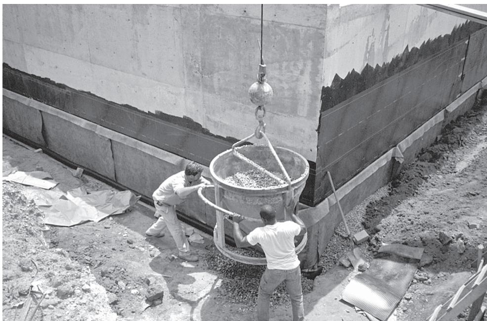
Рис. 2.13. Засыпка гравием области рядом с фундаментом (предоставлено Webtec, Inc.)
