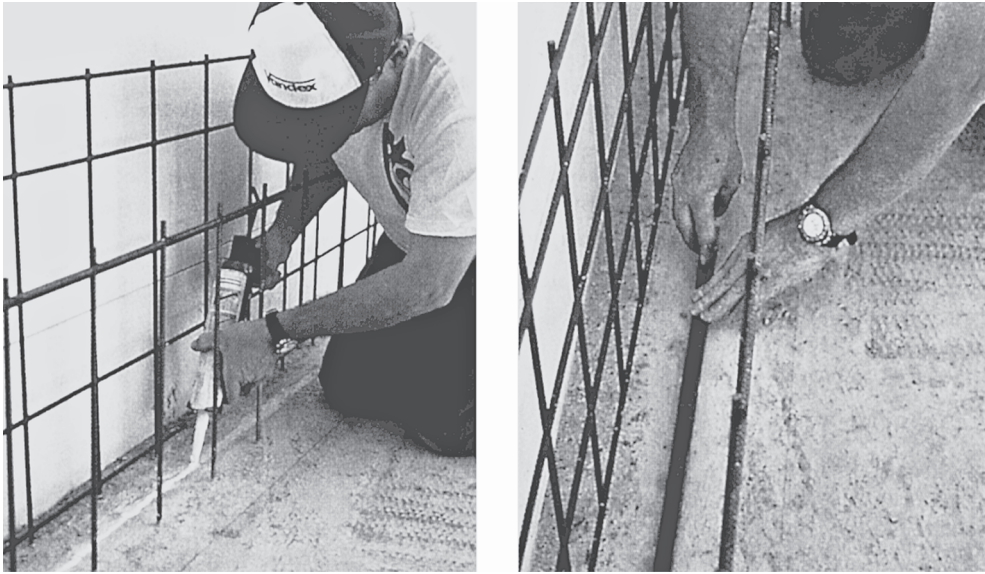
Рис. 2.33. Установка гидрошпонки разбухающего типа
