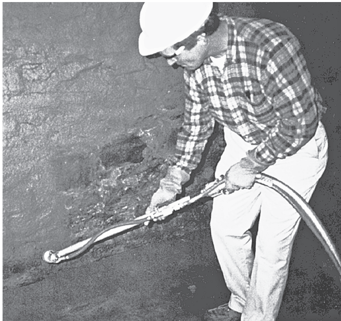
Рис. 2.35. Нанесение цементной гидроизоляции на сторону отрицательного давления
