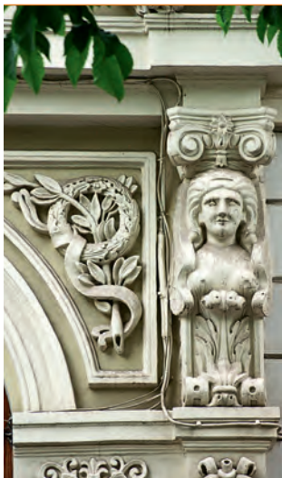
Элемент фасада здания стоматологической поликлиники
