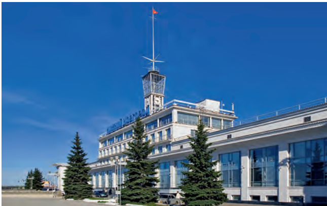
Здание Речного вокзала
